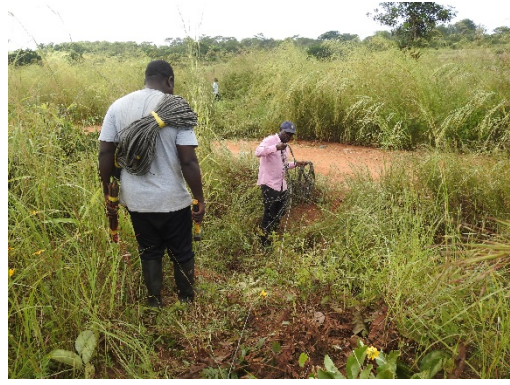
Instalação de cabo de sinal (Mandimba)
