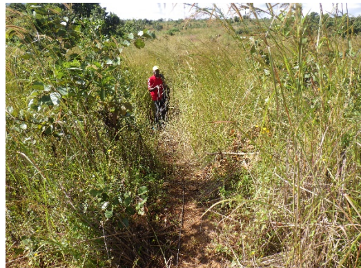
Recolha dos cabos de sinal (Muembe)
