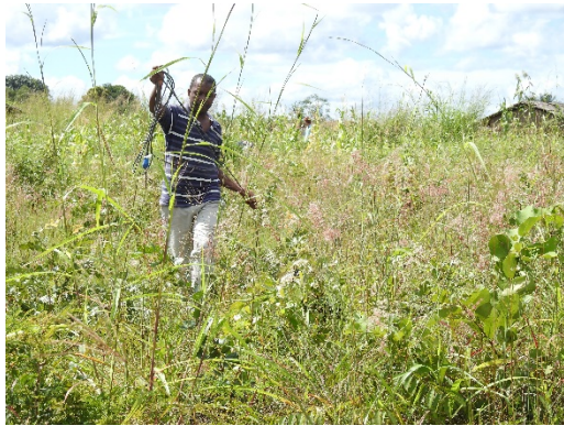
Instalação de cabos eléctricos (Malanga, Majune)
