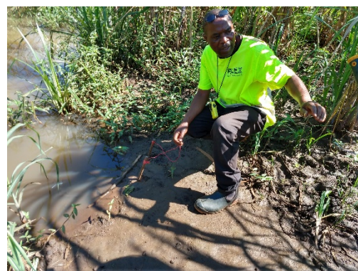
Instalação de electrodo externo (Mandimba)
