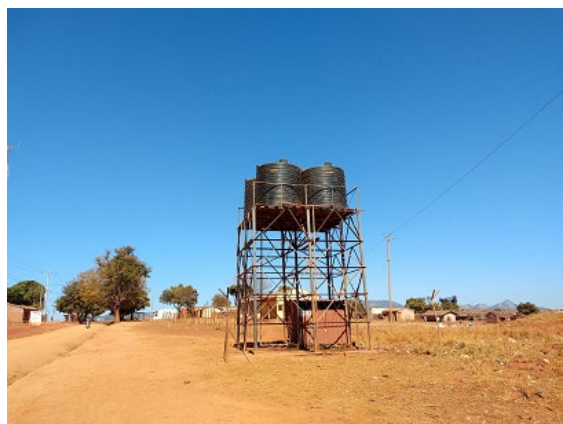
既存高架水槽(ムエンベ郡)
