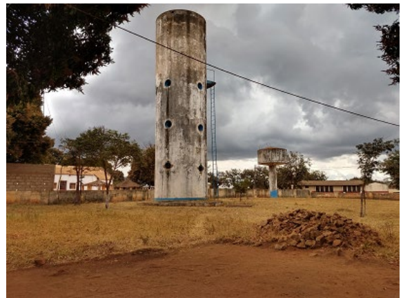
老朽化した既存配水池(マンディンバ市)
