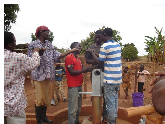
故障したハンドポンプを修理している修理工と村のメンテナンスグループ（ムエンベ郡）
