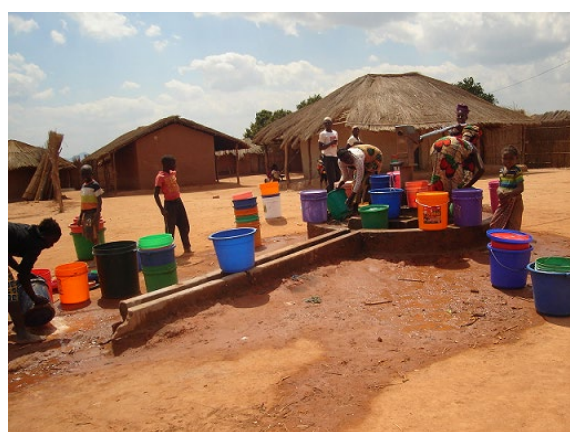
既存ハンドポンプ付深井戸（ムエンベ郡）
