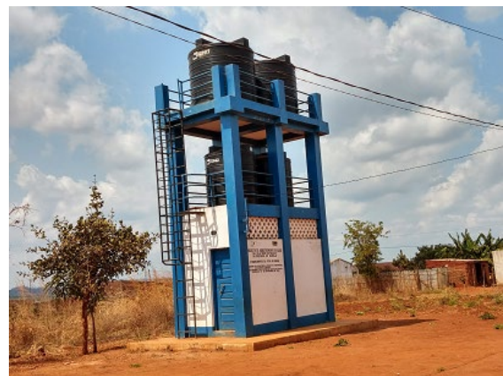
草の根無償で建設された高架水槽(マヴァゴ郡)
