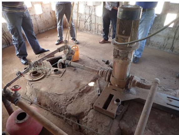
既存揚水施設・浅井戸 (マンディンバ市)
