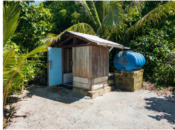
離島のトイレ施設（カヤンゲル州）
