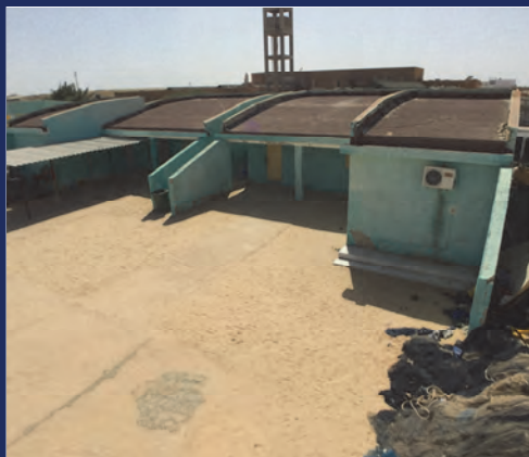
訓練生寮・コンピュータ室外観
