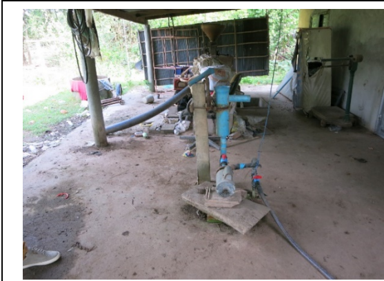
(写真-7) 元のハンドポンプの揚水管にモーターポンプを設置して揚水。
