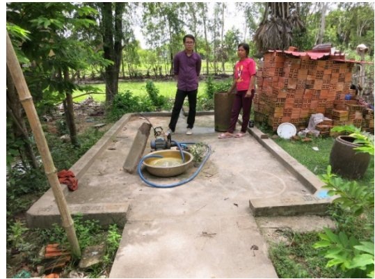
(写真-8) UNICEF が建設したハンドポンプ井戸にモーターポンプを設置。
