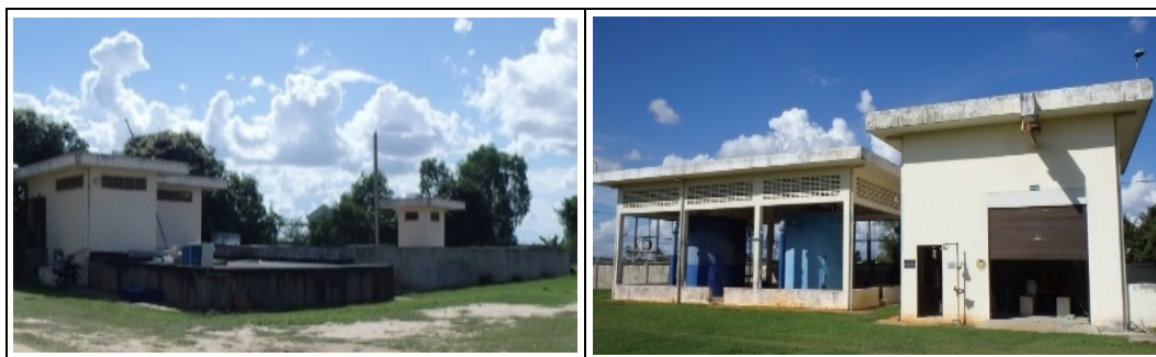
図 2-1-21 既存浄水場（重力式急速ろ過）概況写真、（左）浄水池、（右）ろ過器、塩素注入器
