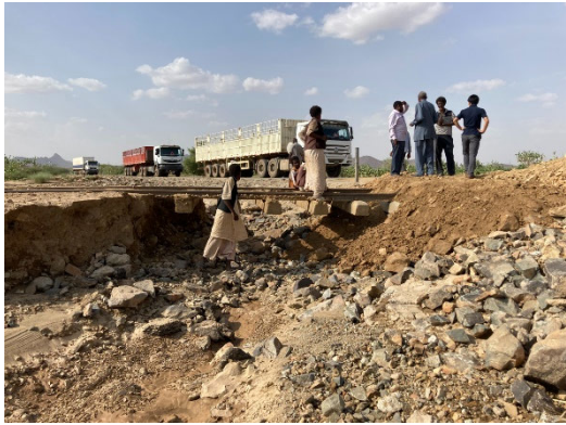
洪水により道床と路盤が流された スーダン鉄道公社の軌道
