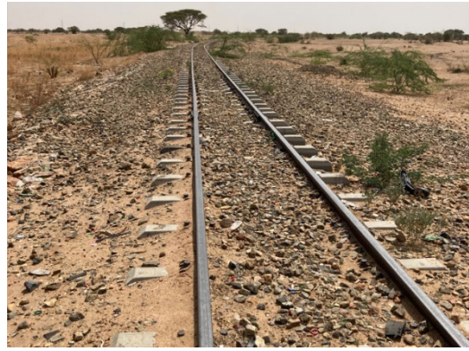
スーダン鉄道公社の鉄道軌道の状況
