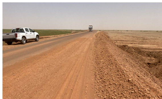
図 2-4-10 洪水による舗装・盛土の崩壊の様子と同区間応急補修後の道路（アトバラ-スアキン間）
