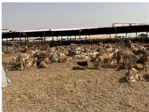
ハルツーム州の検疫所は屋根、フェンスなどのリハビリが必要である
