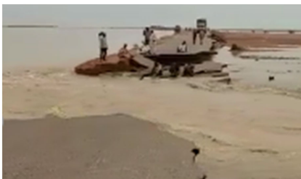
図 2-4-10 洪水による舗装・盛土の崩壊の様子と同区間応急補修後の道路（アトバラ-スアキン間）
