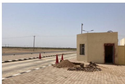
機器設置箇所：対象車両は側線にて計量する（左奥が本線）
