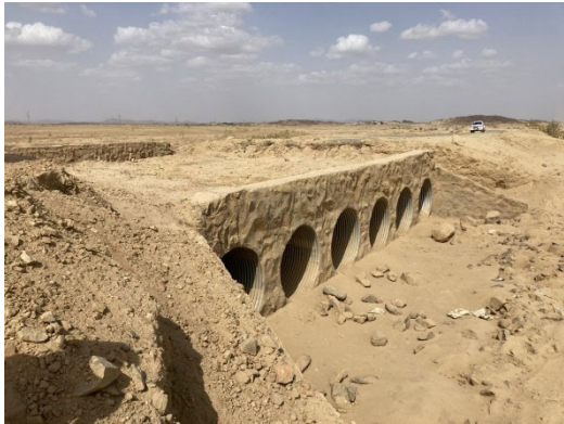
アトバラーハヤ道路に新設された ボックスカルバート
