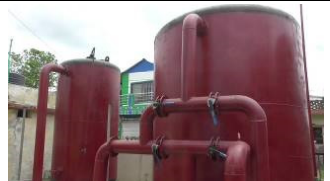
10-2 NWSC 以外の簡易水道 (Pichara WUSC 鉄・マンガン除去装置)
