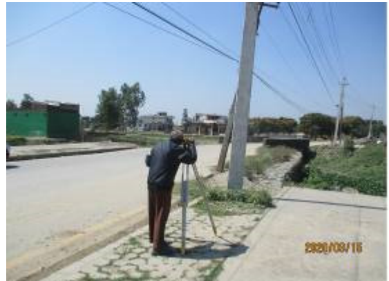
16-4 測量調査 路線測量の様子
