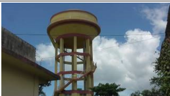
3-1 Munal Path ポンプ場 (高架水槽から配水している)
