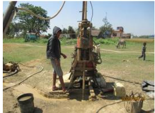
16-2 土質調査 ボーリング工事の様子 (15m)
