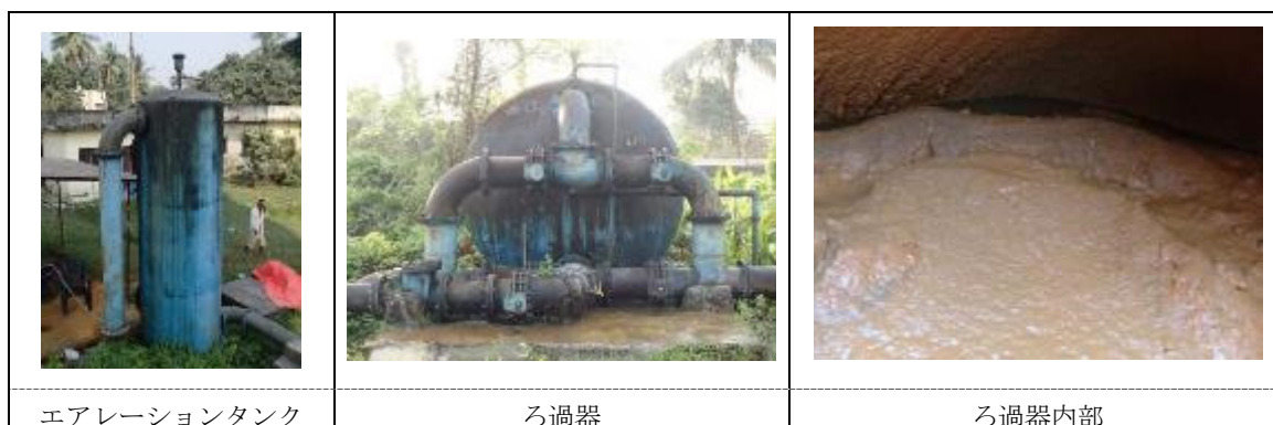
写真 2-1-2 Rani PS 除鉄・除マンガン設備
