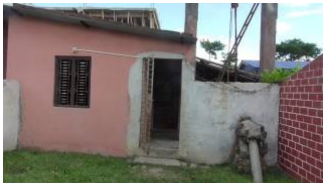
7-1 Pichara ポンプ場 (直接配水している 建屋中に井戸有)
