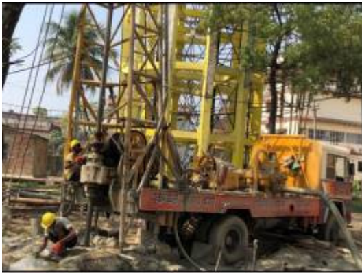
16-1 井戸掘削工事 井戸掘削時の施工の様子 (150m)
