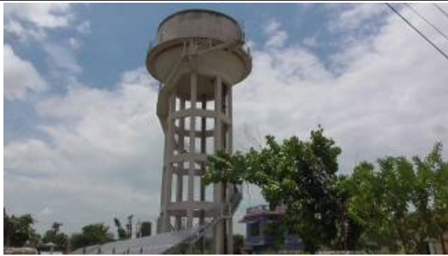
9-1 NWSC 以外の簡易水道 (Jamungachhi WUSC 高架水槽)
