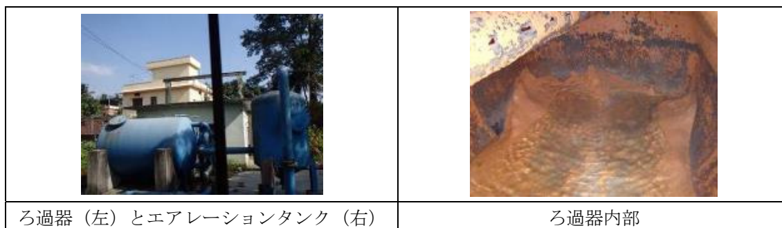
写真 2-1-1 Munal Path PS 除鉄処理設備
