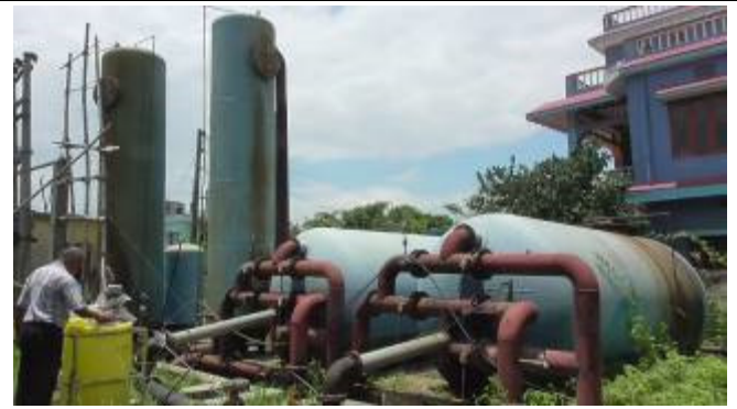
9-2 NWSC 以外の簡易水道 (Jamungachhi WUSC 鉄・マンガン除去装置)
