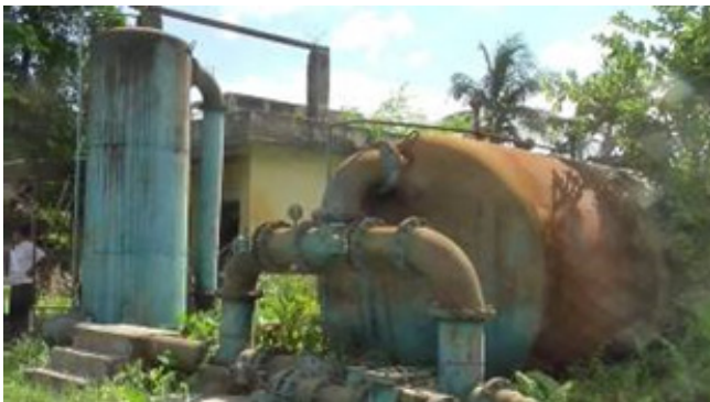
6-1 Rani ポンプ場 (鉄・マンガン除去装置を使用中)
