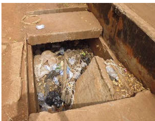
北側道路に敷設されている側溝。ゴミが蓄積しており排水に支障をきたしている
