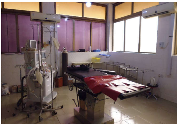
タマレ中央病院：手術室 室内を清潔に保つことに配慮した建築仕様や空調システムとなっていない。
