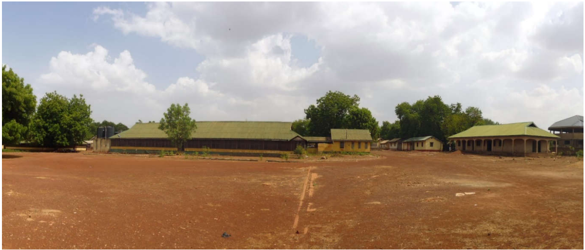
タマレ中央病院：建設候補地の現況 左側が小児病棟、右側が隔離病棟である。工事着工前に小児病棟等の解体・撤去が必要である。
