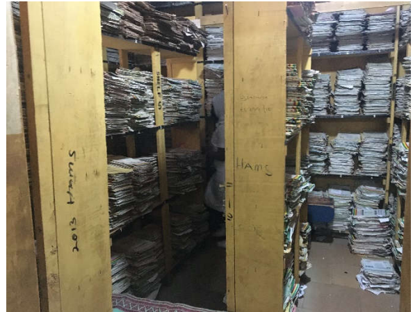
タマレ中央病院：一般外来棟 カルテ庫 一般外来棟のカルテ庫は狭小のため、産前産後棟にも増設して使用しているが、運営上は非効率である。
