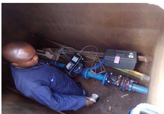
漏水調査 Qm 3 /mf 測定
