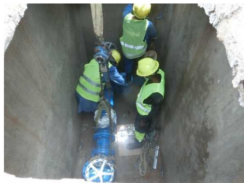
マンホール内流量計の設置作業
