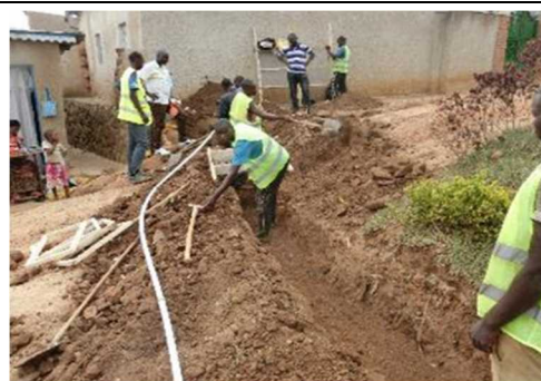
給配水管更新作業
