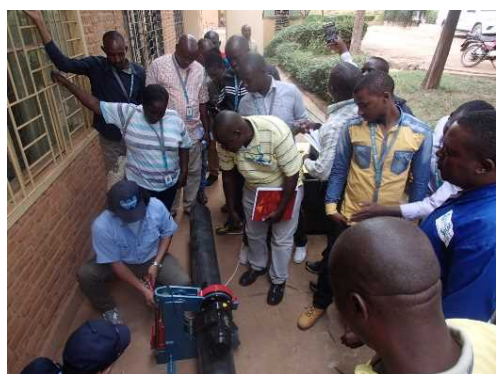
給水管修理の実習
