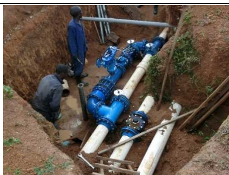
PRV 設置作業
