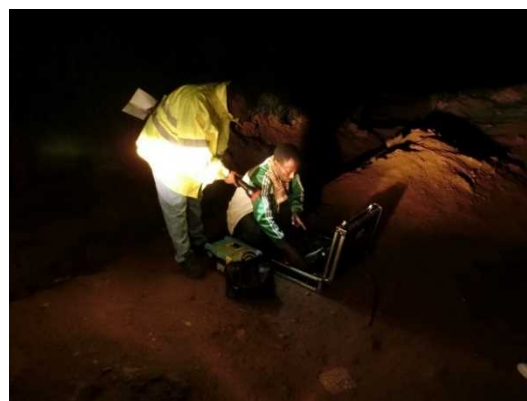
漏水調査 Qm 3 /mf 測定
