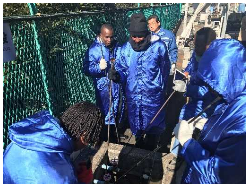
第1回本邦研修 漏水探知実習
