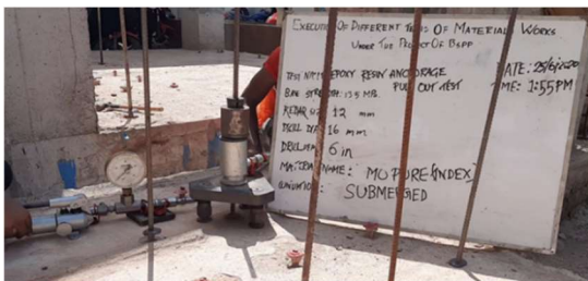
Materials tests (Pull-out test)
