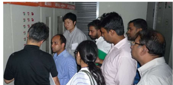
設備関係の現状視察点検
