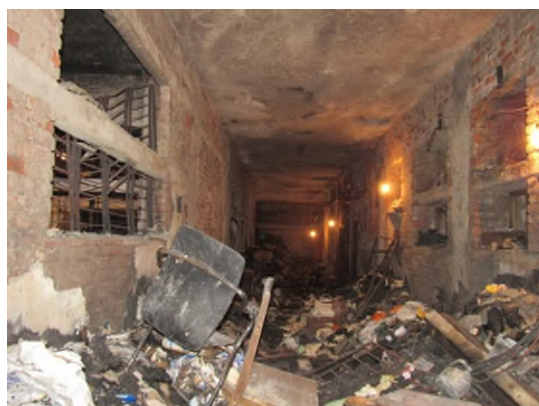
図 2.11.6 火災が起きたゴミ置場(BSPPによる) 図 2.11.7 煙道となった階段(BSPPによる)
