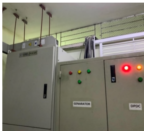
図 2.11.8 埃の溜まったスイッチ盤 (BSPP による) 図 2.11.9 表示サインの無いランプ (BSPP による)
