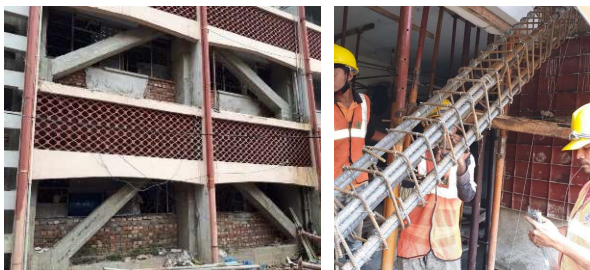
PWD-HQ 改修施工
