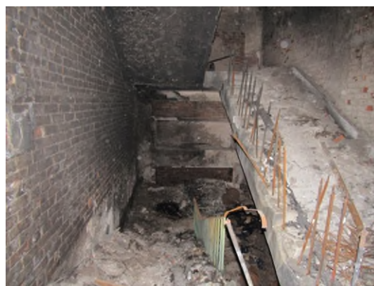
図 2.11.6 火災が起きたゴミ置場(BSPPによる) 図 2.11.7 煙道となった階段(BSPPによる)
