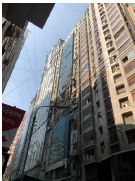
図 2.11.4 火災が起きた Banani のビル (F. R. Tower) 外観 (BSPP による)
