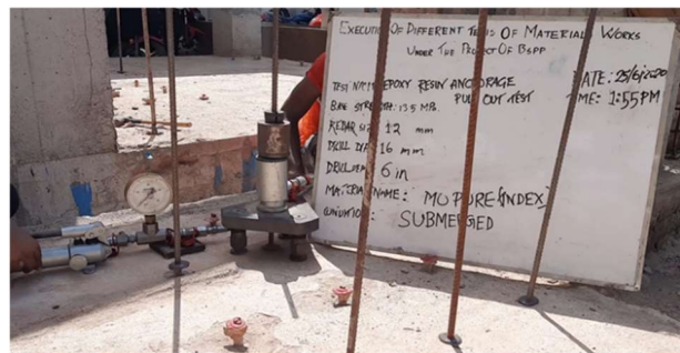
材料試験の状況（引張試験）
