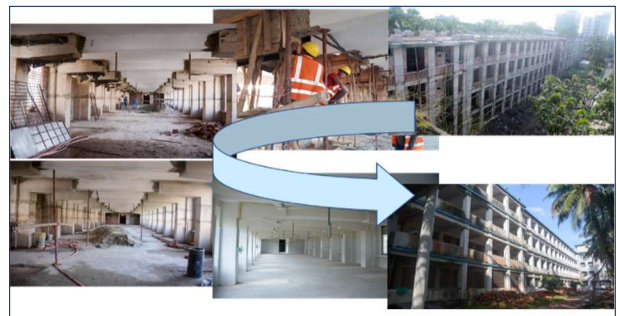
MMCH の改修状況
