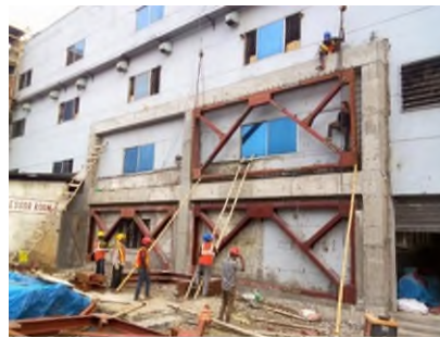
図 3.5.1 DK の耐震改修での鉄骨ブレースの設置
