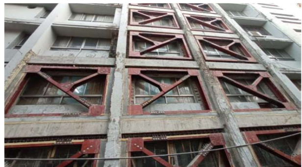
BMD 改修施工
