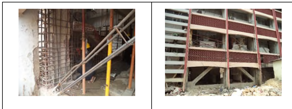
図 2.8.5 施工中のRC造ブレース
