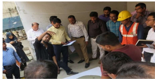
材料試験の説明風景（パイロット研修時）
