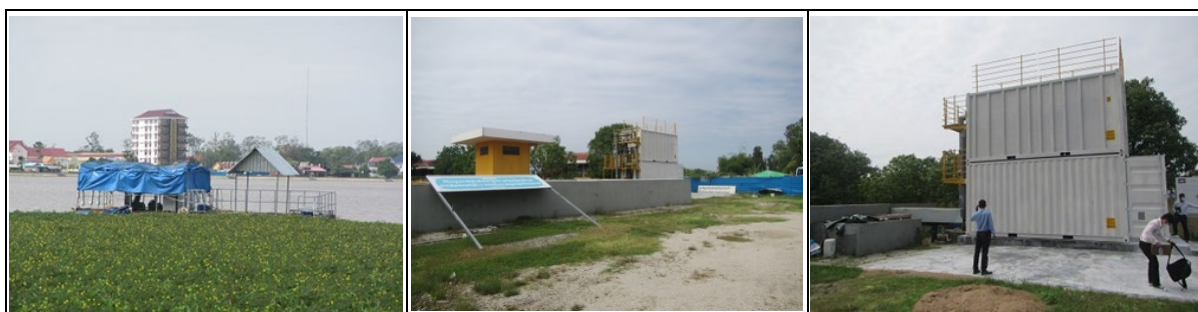
図 2-1-22 既存浄水場（膜ろ過）概況写真 （左）取水施設 （中央・右）膜ろ過装置
