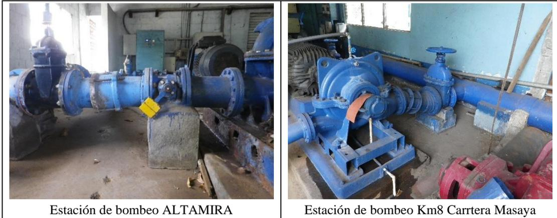
**Foto 2.2.1 Centraje Defectuoso de las Bombas Existentes**
