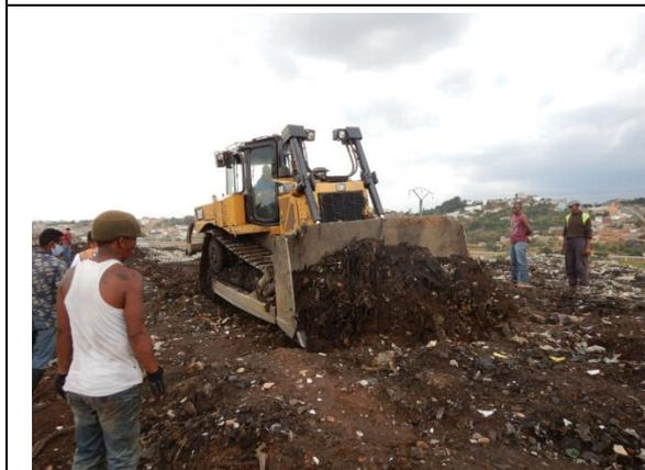
【写真 9】 アンジャランチ最終処分場構内で廃棄物の押出、転圧を行っているブルドーザ。広大な敷地でわずか1台が稼働している。(2021年11月)
