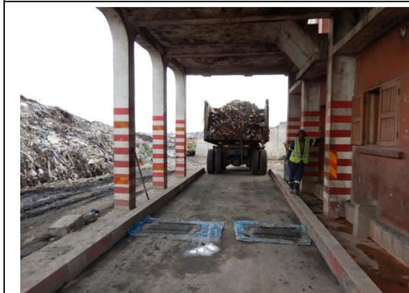
【写真 11】 アンジャランチ最終処分場の受付(トラックスケール)を通過する収集車両(ダンプトラック)。(2021年11月)
