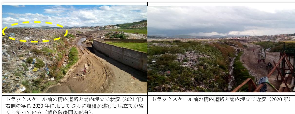
写真 2-6 アンジャランチ最終処分場内の埋立状況 (2020 年と 2021 年との比較写真)
