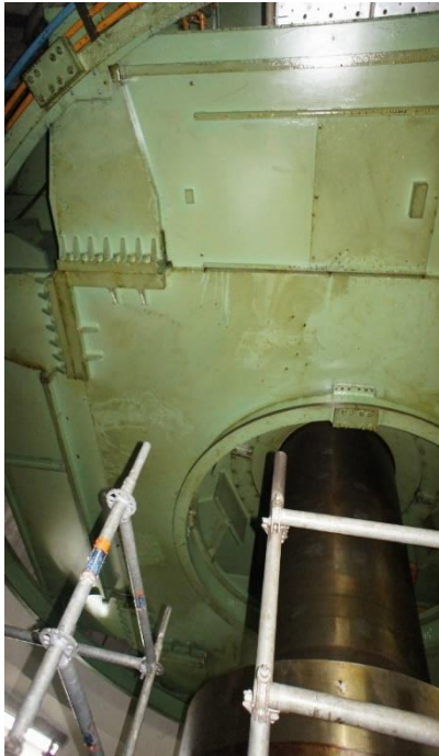
図 3-3.2 点検中の G24 スラスト軸受装置下部を水車室から撮影した状況
