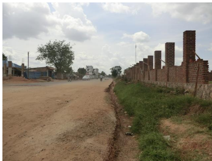
写真 3-2-4 橋梁 No.10 の取り付け道路の現状 (道路舗装まで完了)
