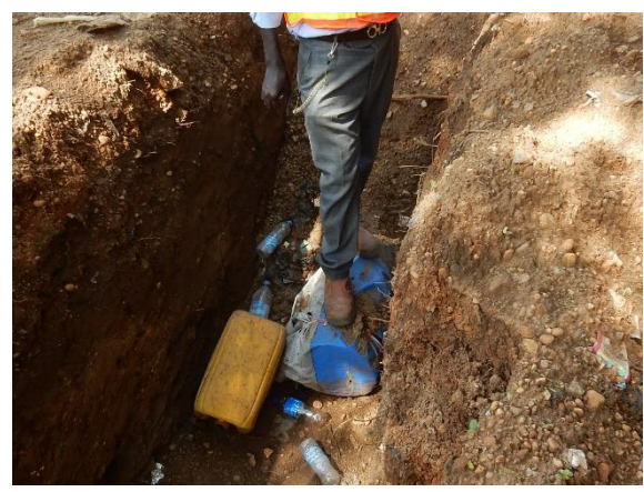
No.7 橋で設置作業中のパイプ (φ300)
