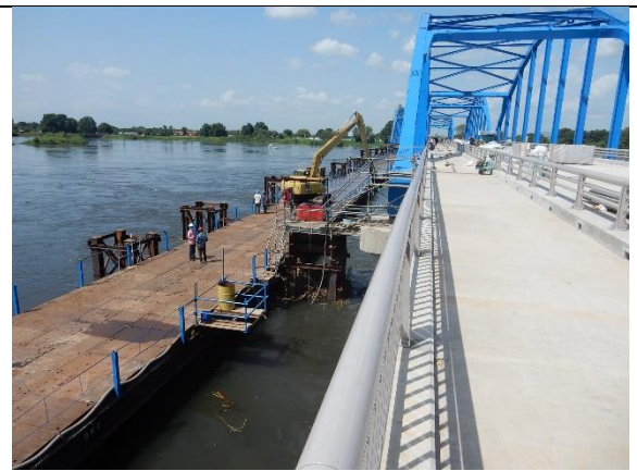
新ナイル橋の建設状況
