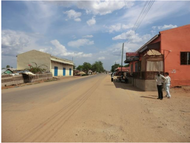
写真 3-2-2 橋梁 No.4 の取り付け道路の現状 (道路舗装まで完了)
