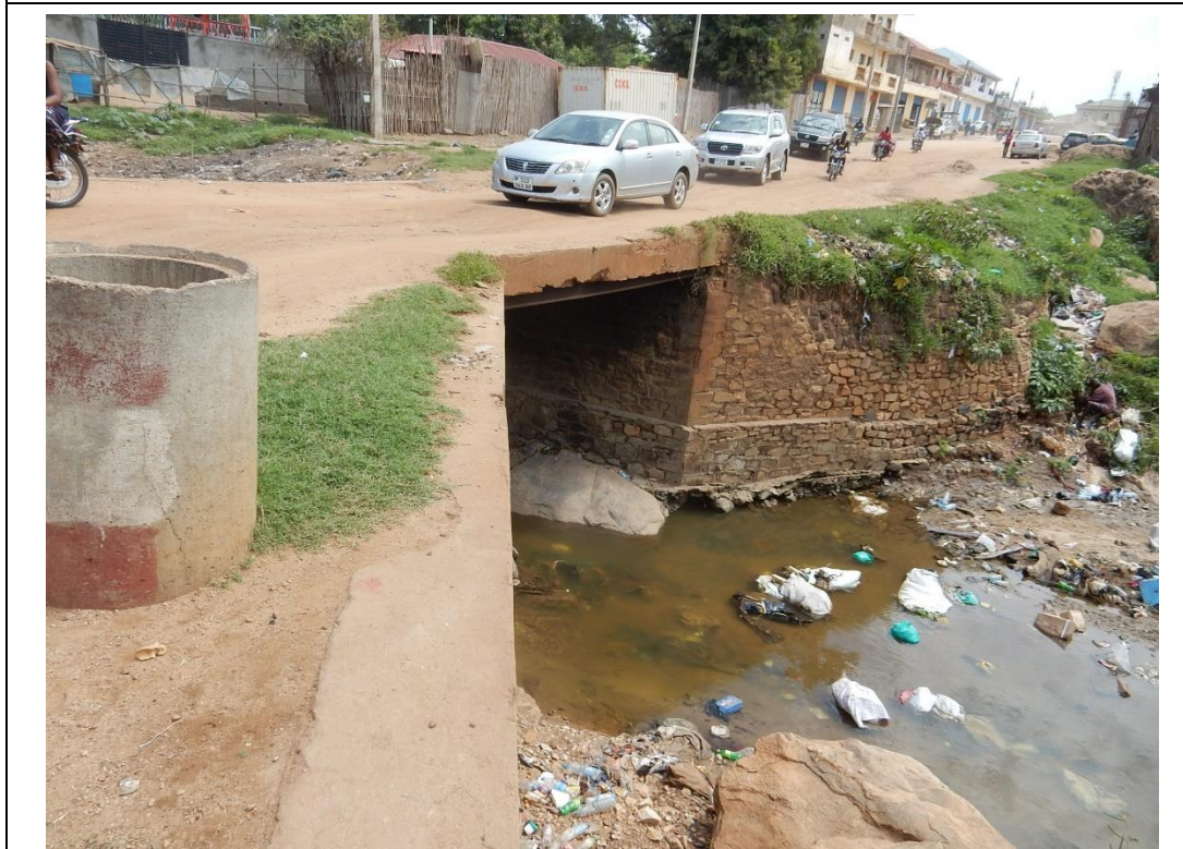
橋台付近（右岸下流側）から望む
