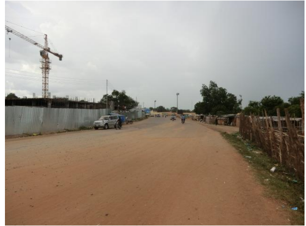
写真 3-2-3 橋梁 No.7 の取り付け道路の現状 (道路舗装まで完了)
