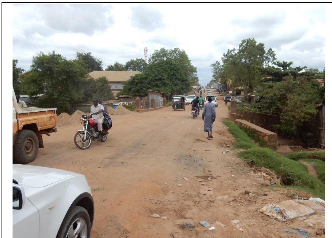
道路上始点側（左岸側）から望む
