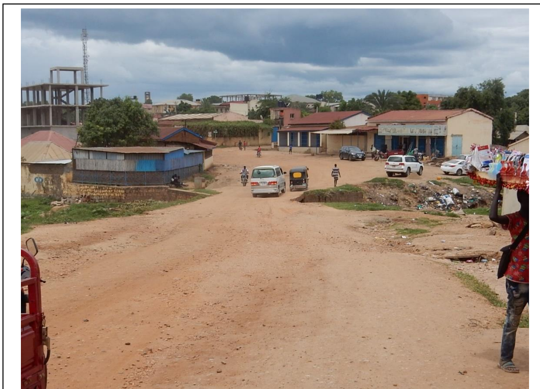
道路上始点側（左岸側）から望む
