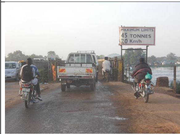
旧ジュバ橋の現況
