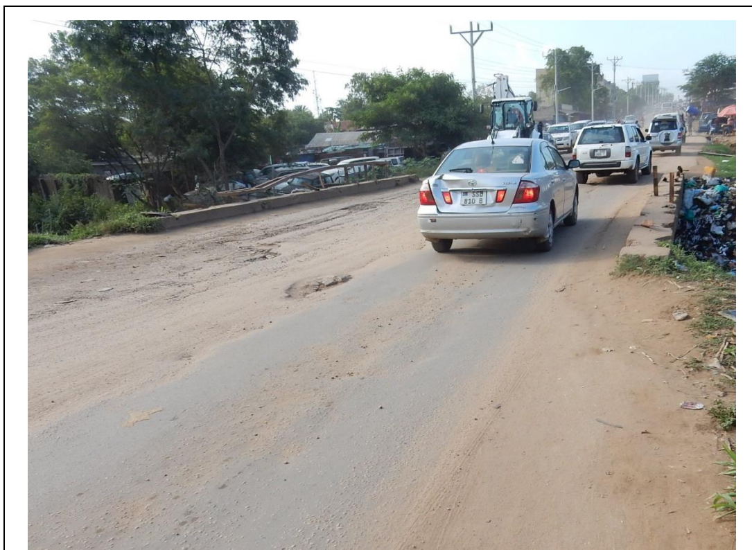
道路上右岸側（終点側）から望む
