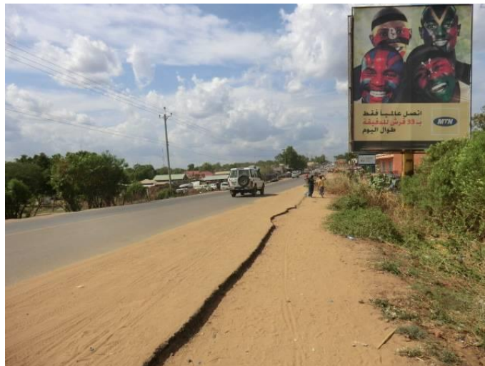
写真 3-2-1 橋梁 No.1 の取り付け道路の現状 (道路舗装まで完了)
