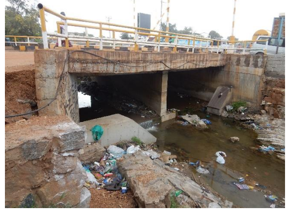
No.22 の橋梁の現況
