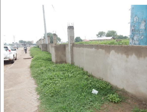
塀が建設された仮設ヤード
