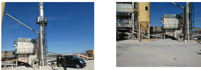
Foto 3-34 Merenje u fabrici asfalta
