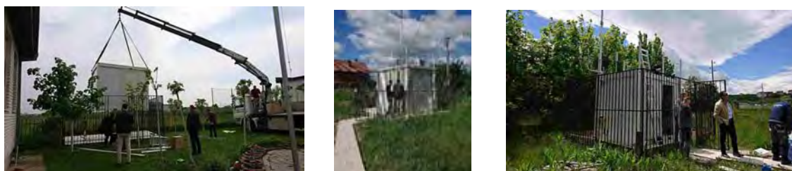
Foto 3-14 Konstrukcija betonskog temelja i zamena kućišta
