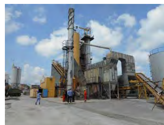
(アスファルト工場)
