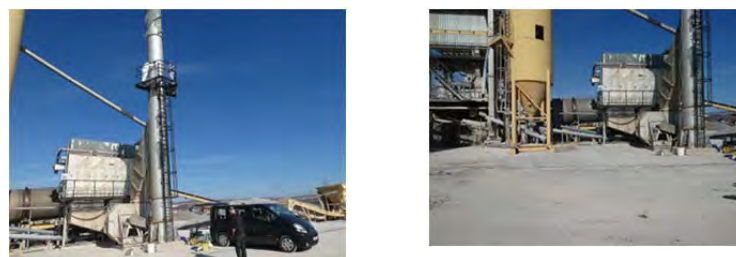
写真 3-3 4 アスファルト工場排ガス測定
