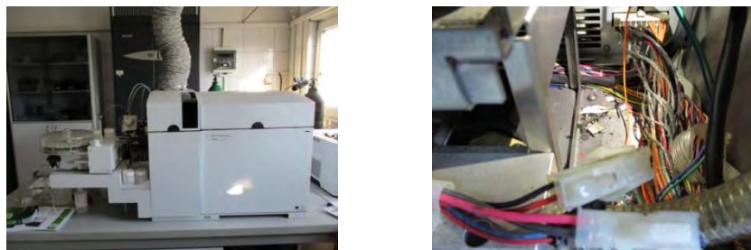
写真 3-2 1 ICP-MS 装置外観と断線が見つかった装置内部
