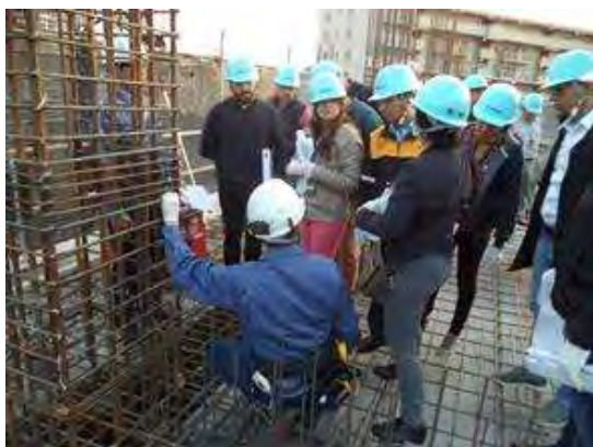
本邦研修：施工品質検査実習（2017年11月15日）
