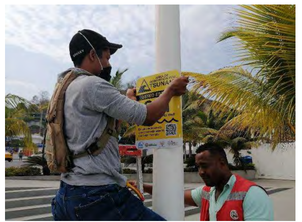
エスメラルダス市標高表示板の設置 (2020 年 11 月 17 日)
