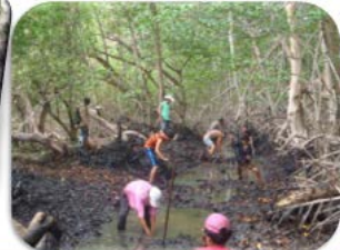
Desalzo de material azulado en un tramo del cauce El Llorón
