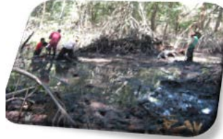
Retiro de sedimento y material seco en el cauce El Llorón
