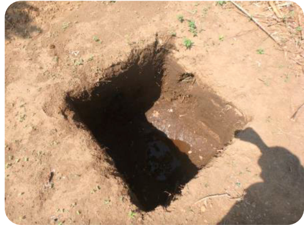
Figura 4. Fosa de Infiltración
