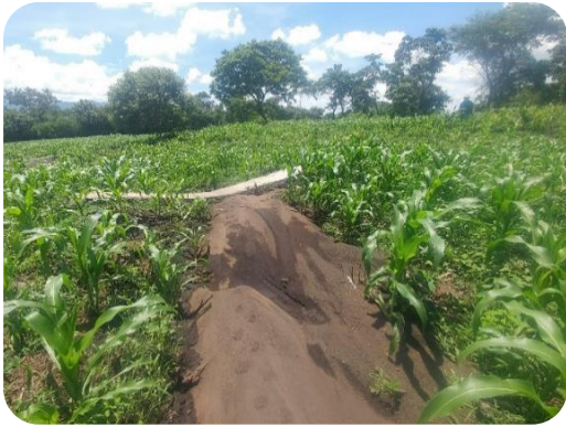
Figura 2. Dique para retención de sedimentos.
