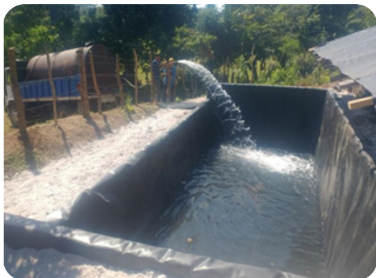
Figura 14. Reservorio cubierto con la geomembrana y siendo llenado con el apoyo de la empresa privada.
