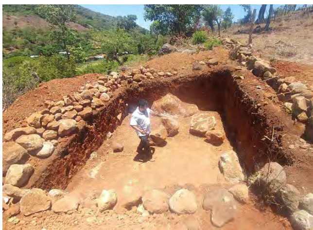
Foto 5: El Sr. Rodolfo de JET fue a las parcelas de Olomega para monitorear el progreso de los trabajos de agroforestería y sistemas silvopastoriles como la construcción del reservorio de agua el 21 de Agosto. (Canton de Olomega)
