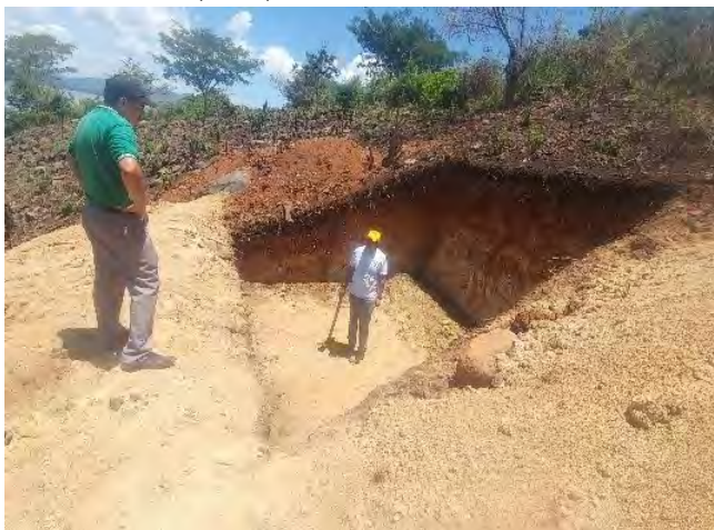
Foto 3: Construcción de unq reserva de agua en el cantón La Estrechura, Laguna de Olomega. Aquí la capa está casi en una etapa completa.
