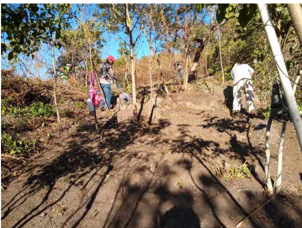
Foto 5: La brecha cortafuegos comenzó a implementarse bajo el acuerdo MARN-Campestre el 23 de febrero (Las Moritas, San Miguel).
