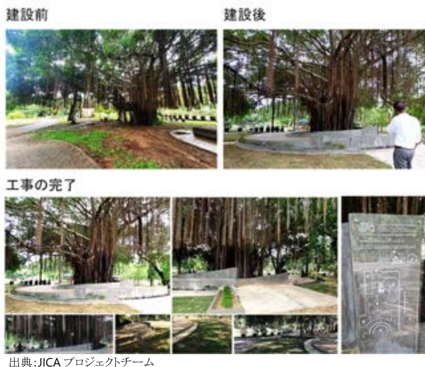
図 4.5 ゾーン D における工事作業と完成後
