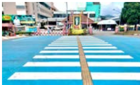
歩道の舗装改良
