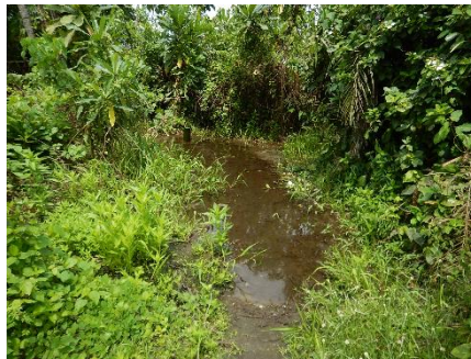
図 4-7 Badagry 変電所の周辺状況
