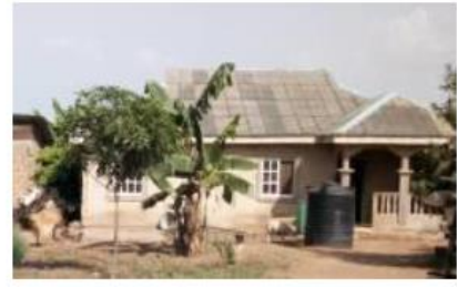
Berese のコンクリート製住居
