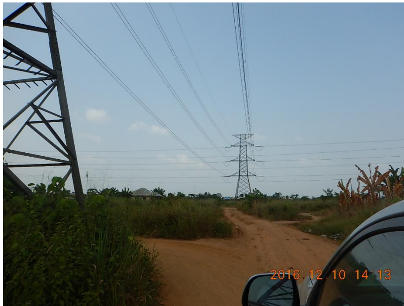
図 4-2 4 Likosi (Ogijo) 変電所予定地の既設送電線
