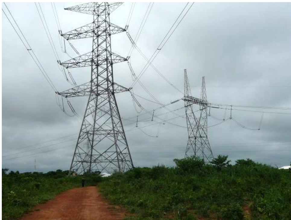
図 4 - 2 6 Ejio (Arigbajo) 変電所周辺の既設送電線
