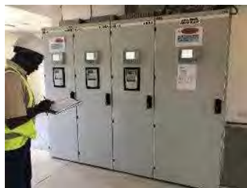
33kV Switchgear
