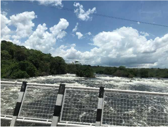
2022年に運転開始予定のカルマ水力発電所近くの河川状況。ここで発電した電力は西ナイル地域へ132kVで送電される予定である。
