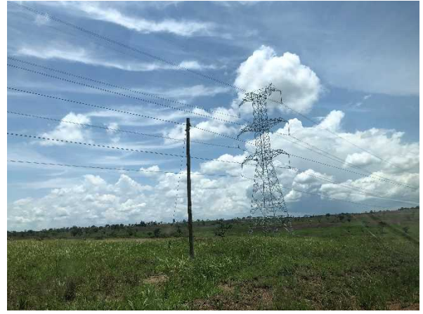
2022年にカルマ水力発電所から西ナイル地域へ132kVで送電される予定である。現在、送電線建設中である。
