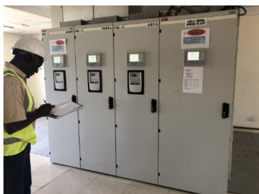
(c) WENRECO スイッチギア(ABB 33kV)
