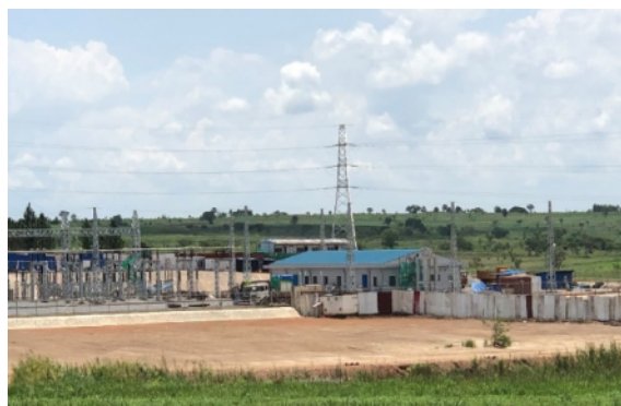
(a) 建設中の送電変電所
