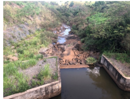
(b) ダムのゲート放流口
