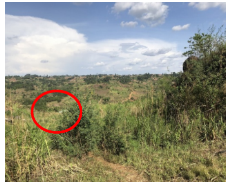
(d) サージタンクから見下ろした Nyagak I 小水力発電所
