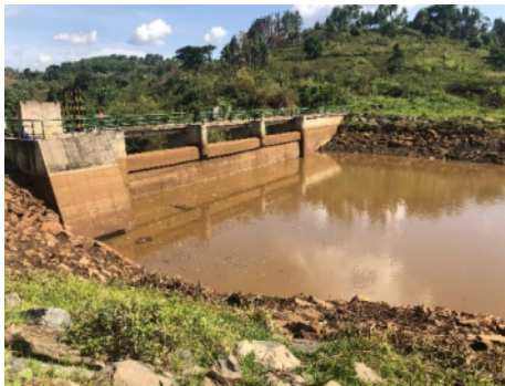
(a) Nyagak I 小水力発電所のダム
