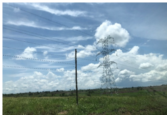
(b) 建設中の 132kV 送電線
