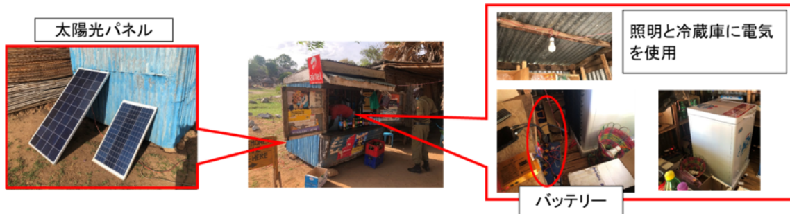
図 4-28 自ら材料を調達し SHS を構築
