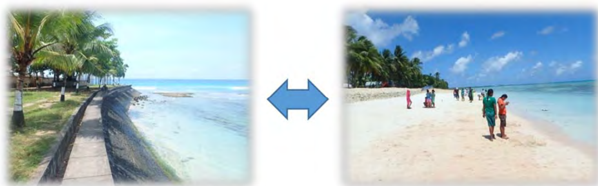
構造物対策（護岸）
