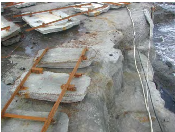
擬岩パネル製作
