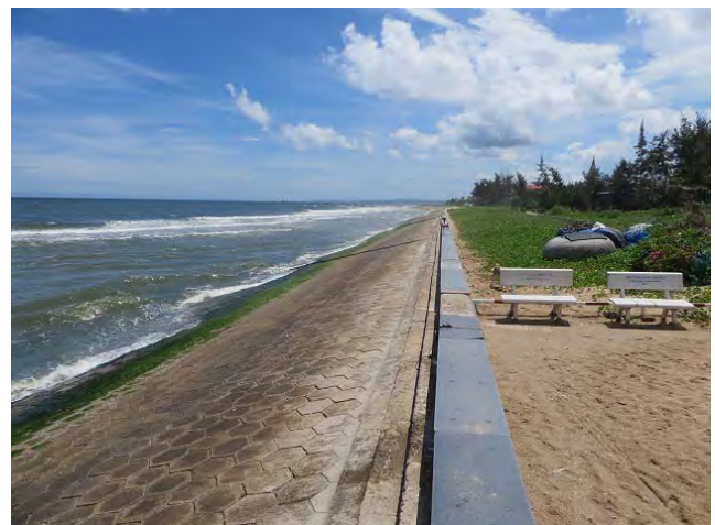
2012年頃に整備された傾斜護岸 (前浜上に建設)
