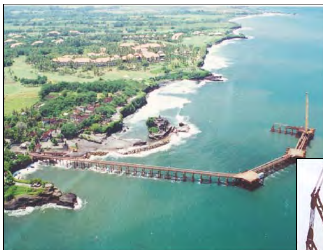
ブロック投入用 仮設栈橋
