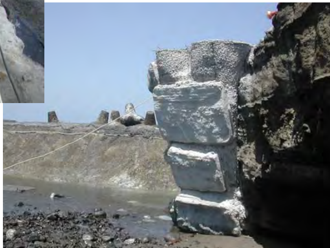
パネル取付け
