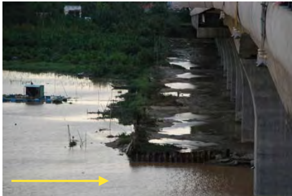
Cua Dai Bridge上流側
