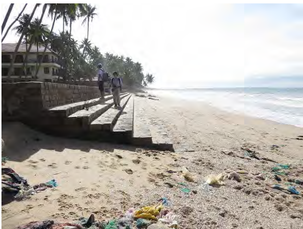
最近建設された護岸(前浜上に建設)
