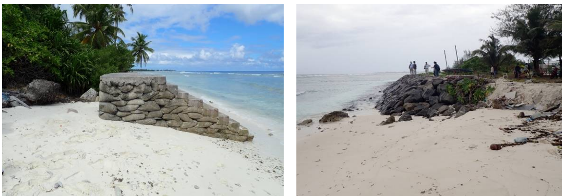
図 2.6.6 前浜上での護岸の設置 (Addu 環礁 Meedhoo 島)
