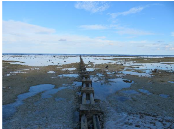
図 2.4.8 Gan 島の下水処理施設（左）及び海への下水放流管（右）
