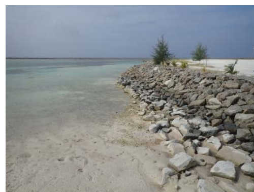
(4) 埋立周辺護岸 (2019 年 2 月)
