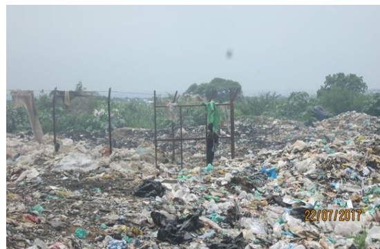
破壊された処分場周辺フェンス
