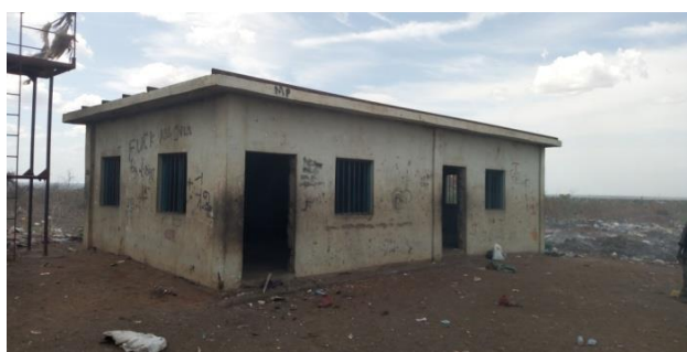
ジュバ最終処分場の管理棟
