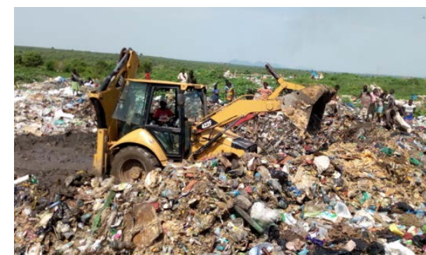
アクセス道路沿いのごみ撤去 レジャフパヤムが借上げた重機により、アクセス道路の改善を図っている (2020年6月1日撮影)
