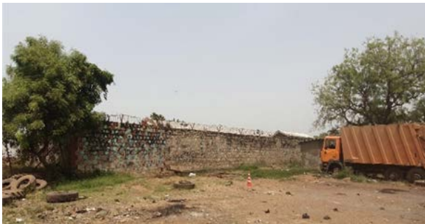
車両整備ワークショップ建設予定地 南西から (2020年11月5日撮影)
