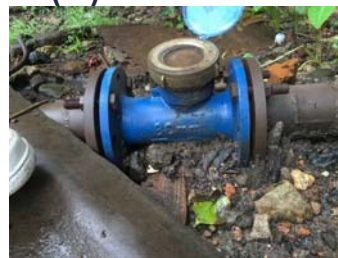
Bulk meter survey
