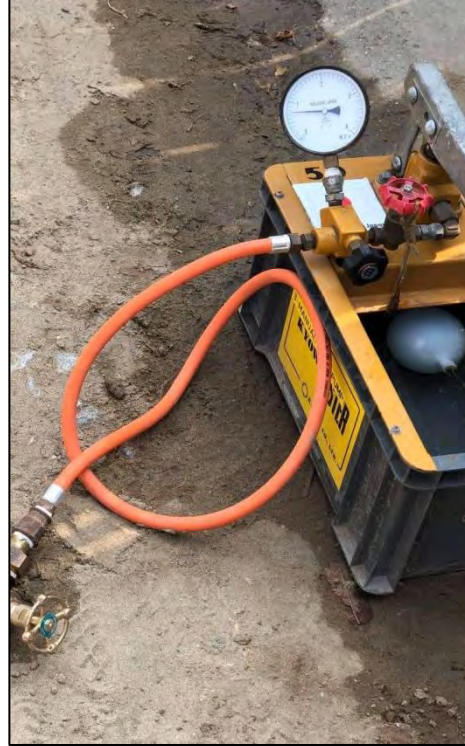
သတ်မှတ် Pressureရောက်ရှိစေရန် Pressure ရိုက်ခြင်း
