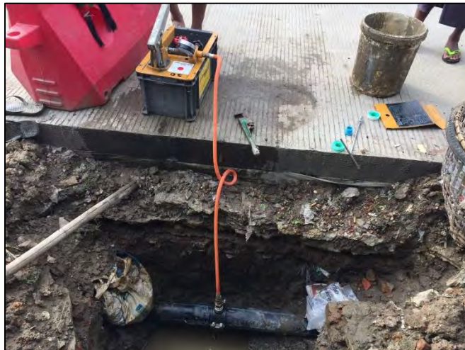
သတ်မှတ် Pressureရောက်ရှိစေရန် Pressure ရိုက်ခြင်း
