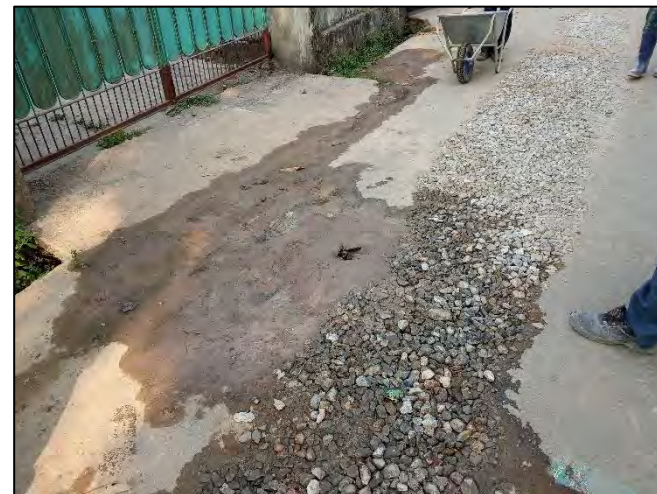
Pressure Test ဆောင်ရွက်ပြီး ကေ ရိရသော ပိုက်ပေါက်နေရာ
