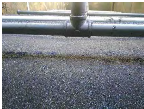
新たに設置された表面洗浄装置 (Phase2 パ イロットろ過池)
