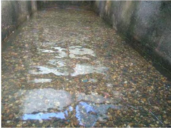
新たに投入されたろ過砂利 (Phase2 パイロットろ過池)
