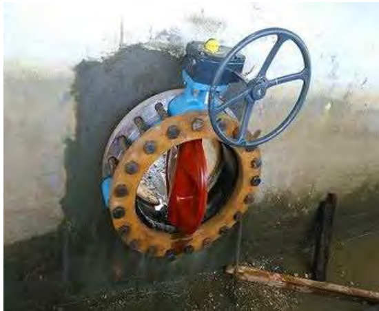
取り替えられた洗浄排水弁 (Phase2 パイロットろ過池)
