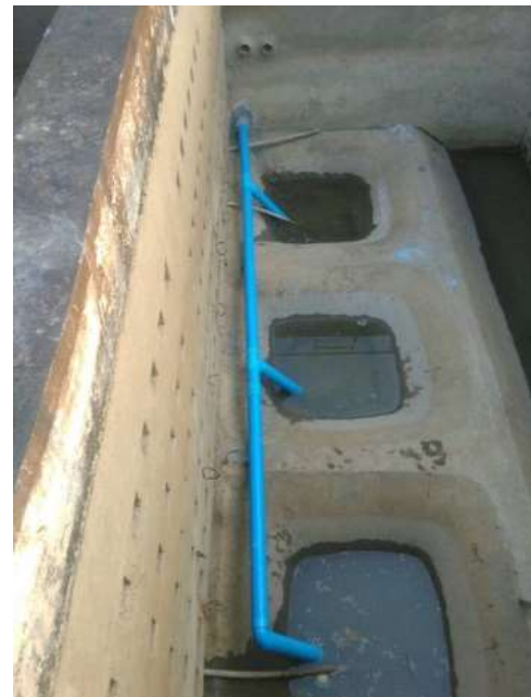
写真 2-71 : Phase1No. 1 沈殿池の修理された排泥パイプ
