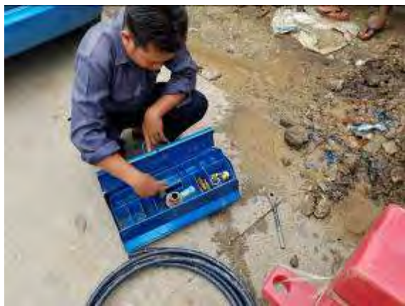
写真 2-49：穿孔機を用いた給水穿孔
