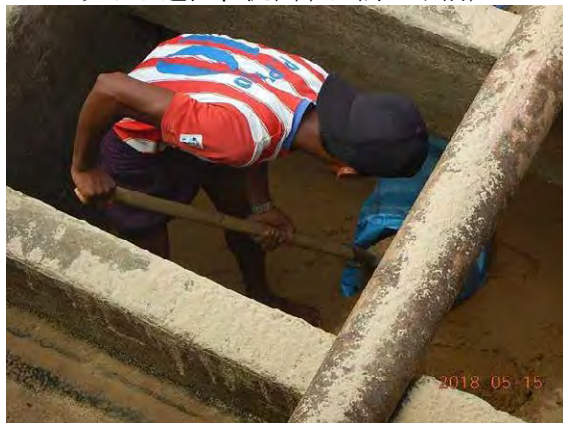
ろ過砂の投入作業 (Phase1 パイロットろ過池)
