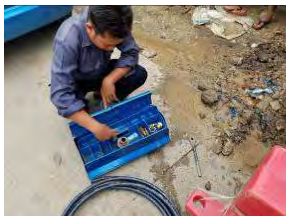
写真 2-43 : 穿孔機での給水分岐
