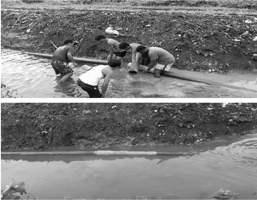
写真 2-35：水路の中に布設されている配水管の水中での漏水修繕
