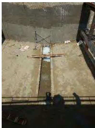
沈殿池底面に片傾斜を設けるための工事
