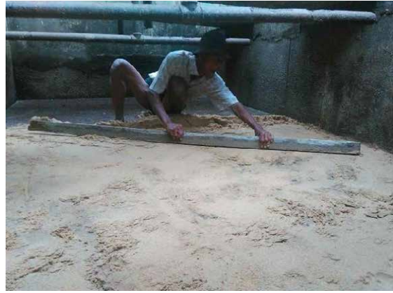
新たに投入されたろ過砂 (Phase2 パイロットろ過池)
