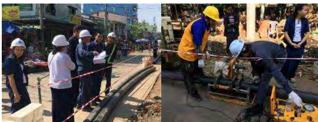
写真 2-46：配水管布設工事
