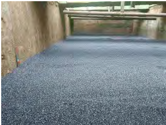
新たに投入されたアンフラサイト (Phase2 パイロットろ過池)
