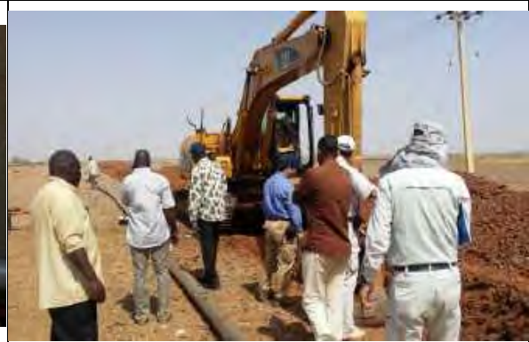
写真-14：白ナイル州水公社職員による管路掘削状況（白ナイル州）。
