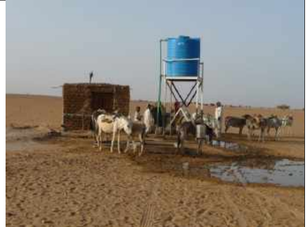
写真-2: 地下水を水源とする小規模な給水施設 (リバーナイル州のミニウォーターヤード)。
