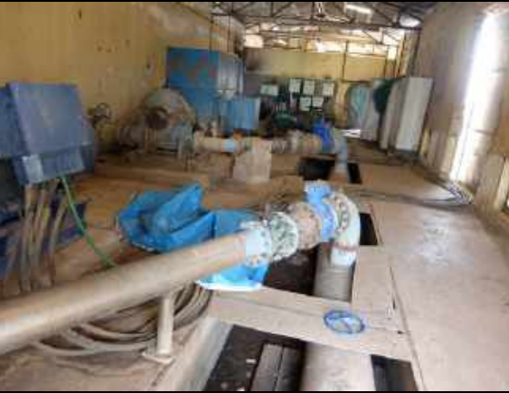
写真-9：ゲダレフ州既存送水管中継ステーション。超音波流量計を中央の管の手前に設置予定（ゲダレフ州）。
