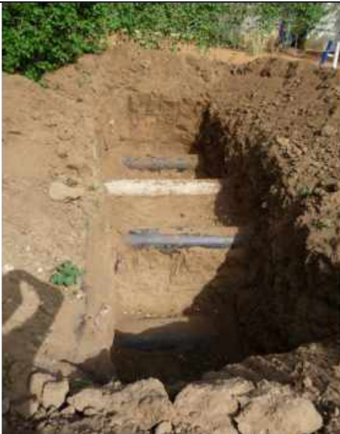
写真-11：管路の敷設状況。流量計の設置予定地点（ゲジラ州）。
