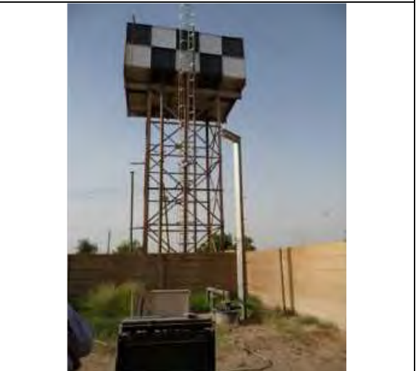
写真-4: ウォーターヤードの標準的な高架配水タンク (北部州)。
