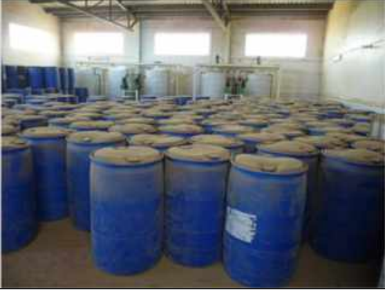
写真-7：PAC（凝集剤）の容器の格納状況（アトバラ浄水場：リバーナイル州）。
