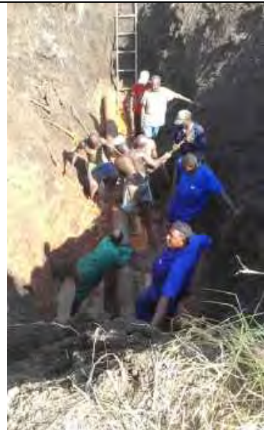
写真-12：既存管路の人力掘削による補修状況。バックホーローダーの調達により掘削効率が改善される（ハワタ・ワドエラガエイリ地区）。
