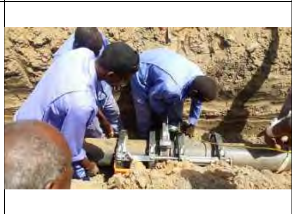
写真-16：白ナイル州水公社職員によるHDPEパイプ接続状況（白ナイル州）。
