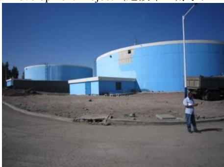
水源開発現地調査：South Ayat North Fanta Ground Water Development Project（建設中の貯水タンク）
