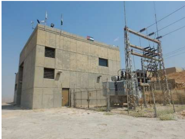
導水ポンプ場外観
