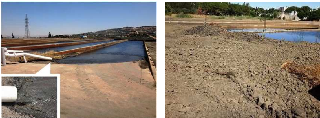
図1.天日乾燥床の状況（左図：汚泥の流入、右図：積み上げられた乾燥汚泥、2019年7月15日）
