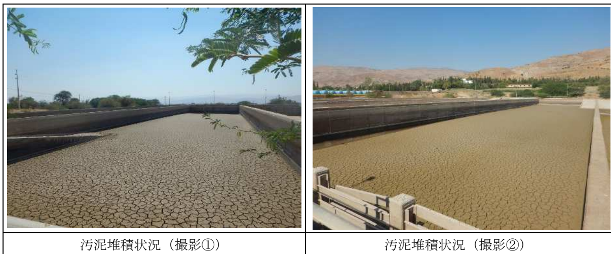
写真- 13 沈砂池 No. 2 汚泥堆積状況
