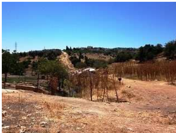
a) ザイ浄水場付近
