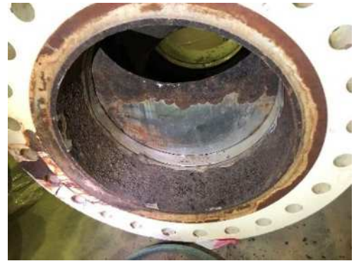
写真- 10 電動ボール弁内部
