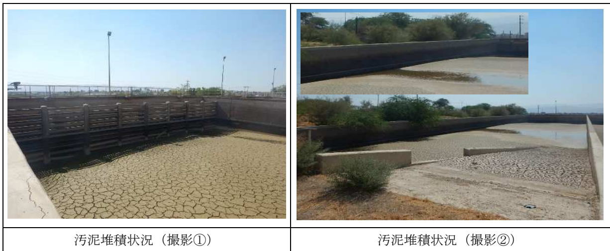
写真- 12 沈砂池 No. 1 汚泥堆積状況
