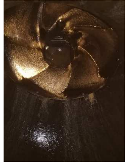
写真- 3 インペラの欠損
