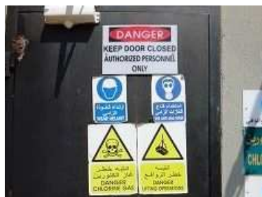
e) 二酸化塩素注入施設の安全標識
