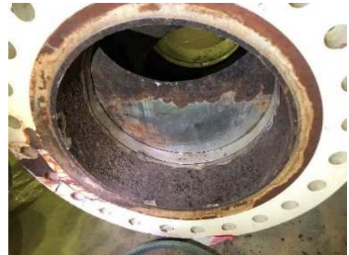
写真- 10 電動ボール弁内部
