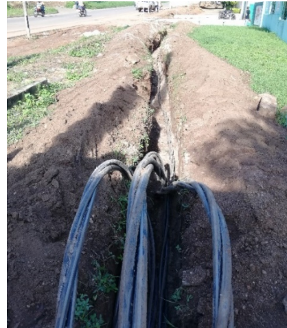
図 4.3-2 地中電線路(工事中)
