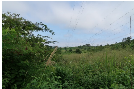
TK08 付近から老側を撮影（雑木、雑草）
