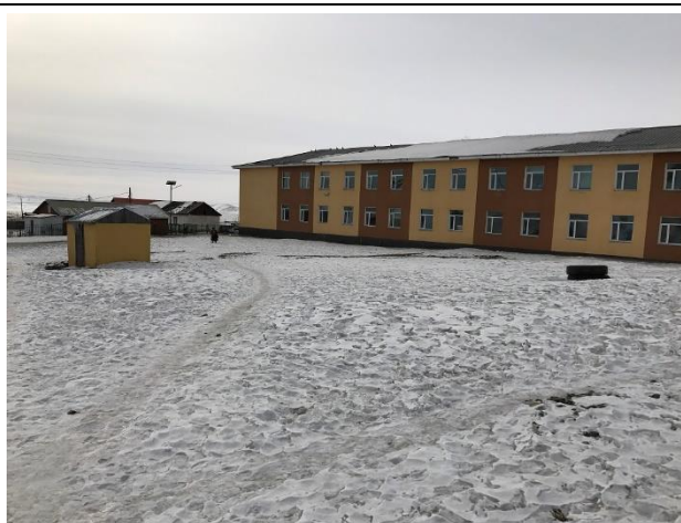
地中熱交換器設置場所(校舎脇)
