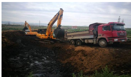
堆積した下水汚泥の搬出
