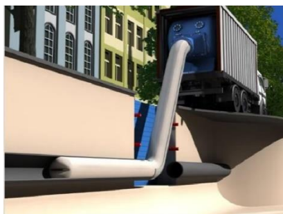
現場硬化管(CIPP)タイプ
