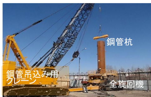
図 3.3 回転圧入鋼管杭施工状況
