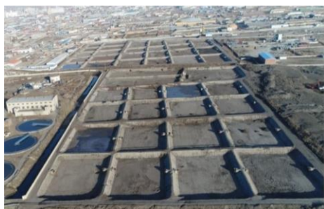
下水汚泥堆積ヤード
