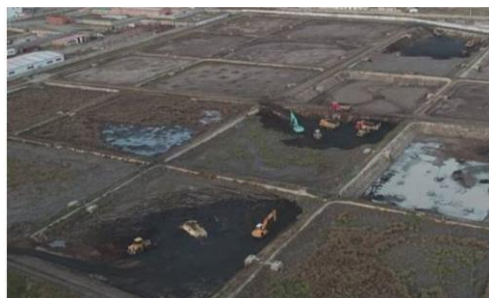
下水汚泥のならしヤード
