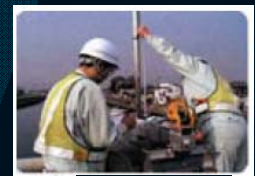
ソナー設置作業
