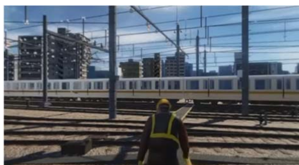
(鉄道車両基地内の作業)
