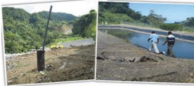
ガス抜き管と浸出水処理施設
