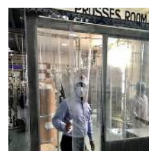
加工室出入口のビニルカーテン
