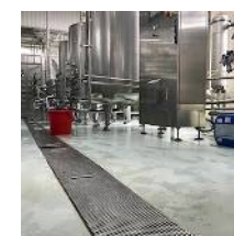
排水溝が整備され、水洗いできる床
