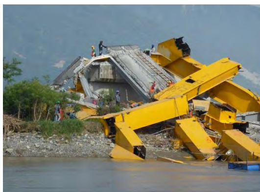
Collapsed Jembatan Palu IV
