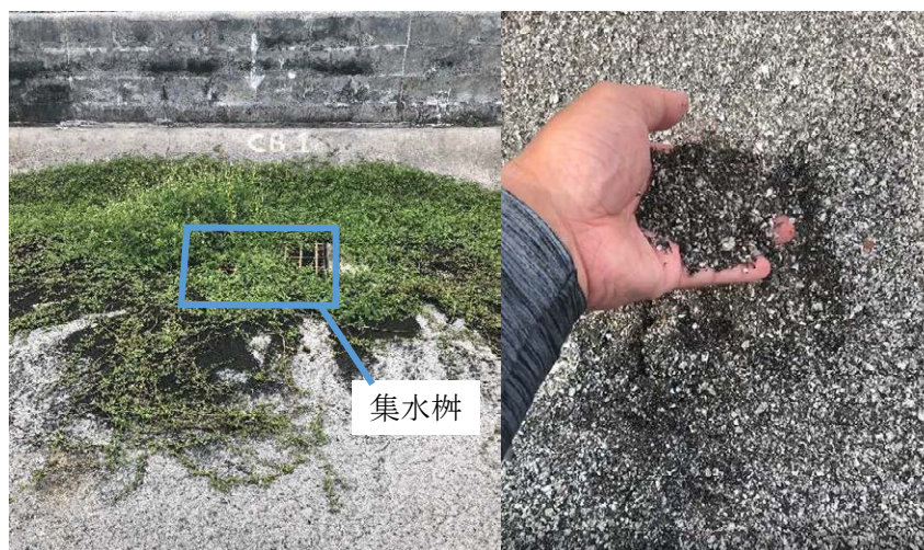
図 1.1-3 埋没した集水桝及び堆積物
