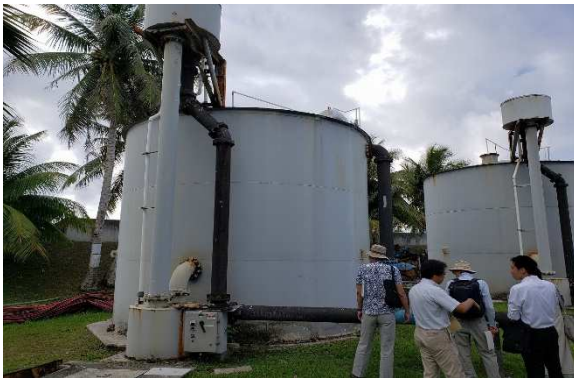
本計画貯水池から雨水が導水される浄水場-C (設計能力：1.1 MGD (約 4,160 m 3 /日))
