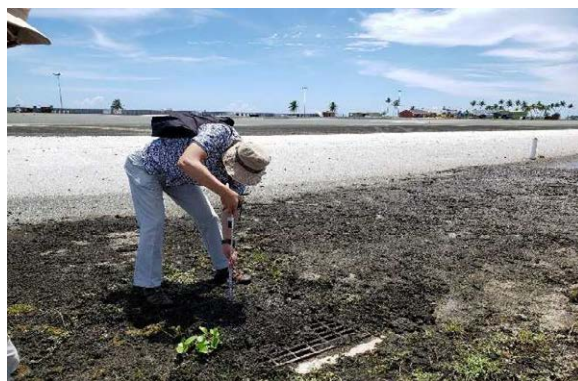
マジュロ国際空港の滑走路 滑走路脇に位置する雨水集水樹の一部
