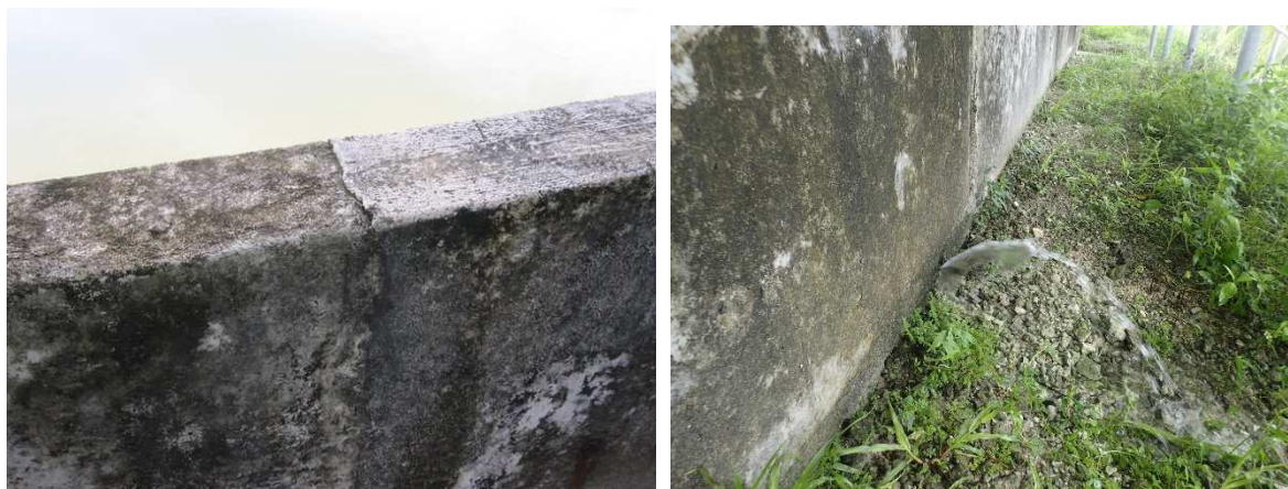
図 1.1-7 逆 T 式擁壁の状況
