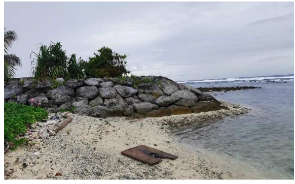
新規貯水池の建設にあたり撤去予定の既存護岸
