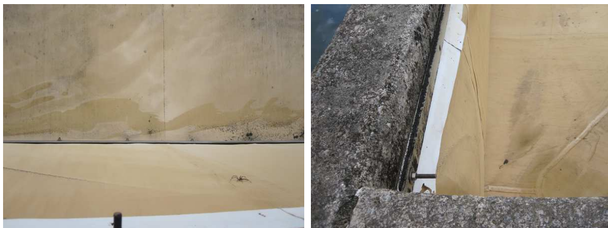
図 1.1-6 遮水シートの状況
