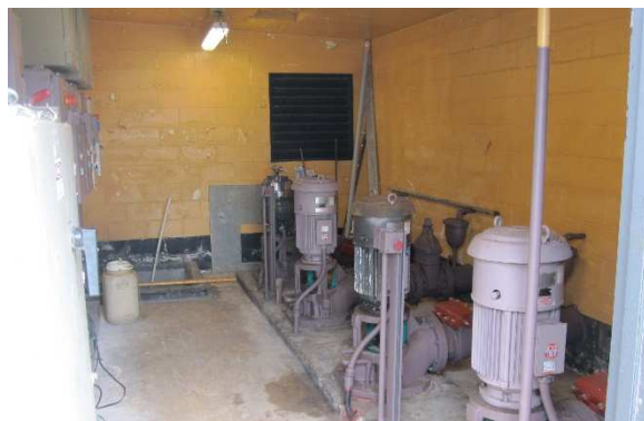
マジュロ国際空港脇に位置する導水ポンプ場 縦軸斜流ポンプ 4 台既存
