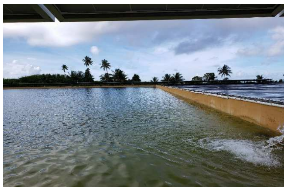
貯水池 No.2 と 覆蓋付き浄水池（右側）
