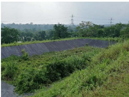
処分場に併設されている浸出水調整池の様子。(2019年10月) 処分場からの排出管はあるものの浸出水が貯まっておらず、草木が生い茂っている。
