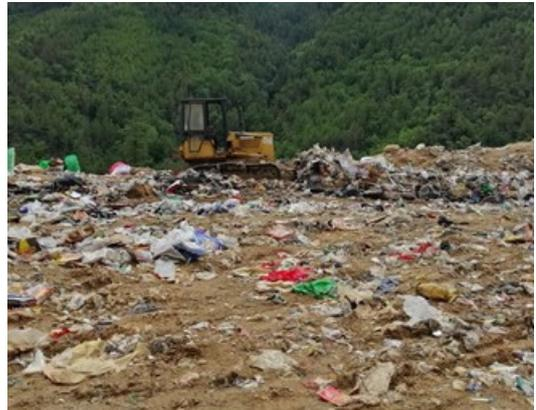
処分場でのブルドーザー(2007年製)による転圧・敷き均しの様子。ブルドーザーは小型のため、転圧がしっかりとされていない。(2019年8月)
