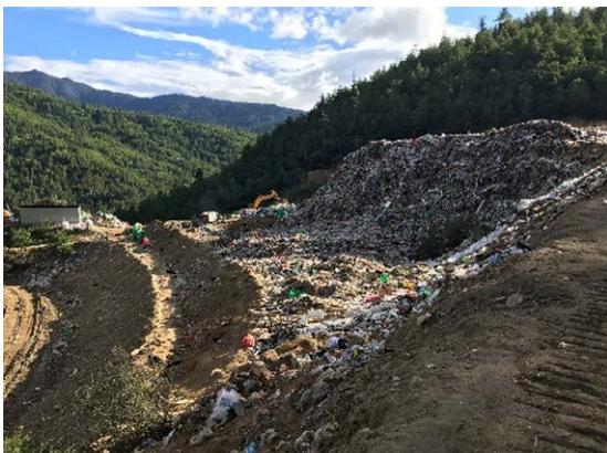
市の処分場の風景。斜面上部から下部への落とし込みによる処分となっている(2019年10月)。残余年数は約3年であり、JICA草の根技術協力により、処分場の一部拡張工事が進められる予定である。
