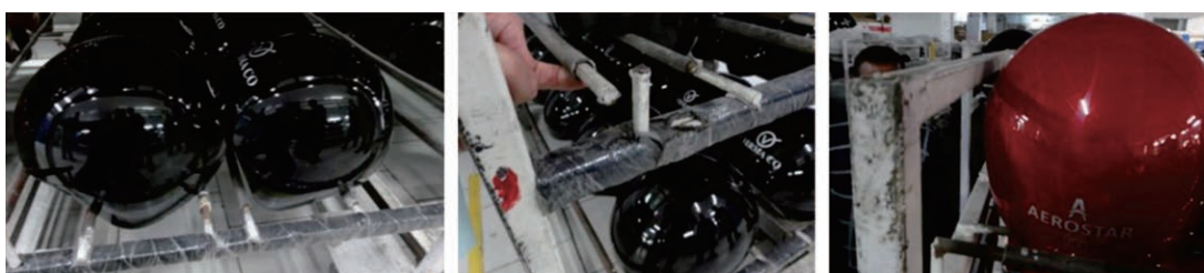
図23 搬送トロリーの補修作業
