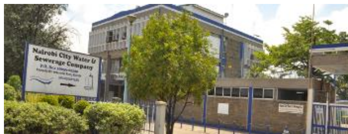
写真 NCWSC 外観
