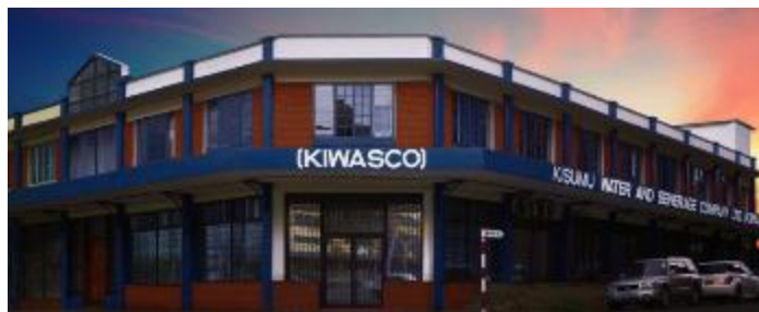
写真 KIWASCO 外観
