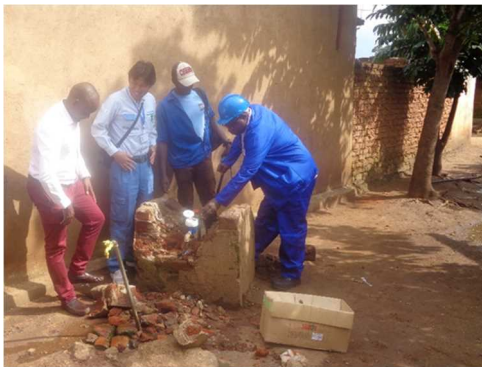
D3 水道メータ交換作業 2020年2月
