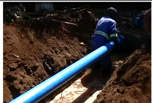
配管修理 2019年7月
