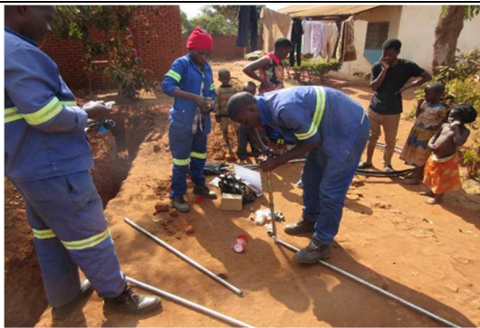
新規配管接続 2019年7月
