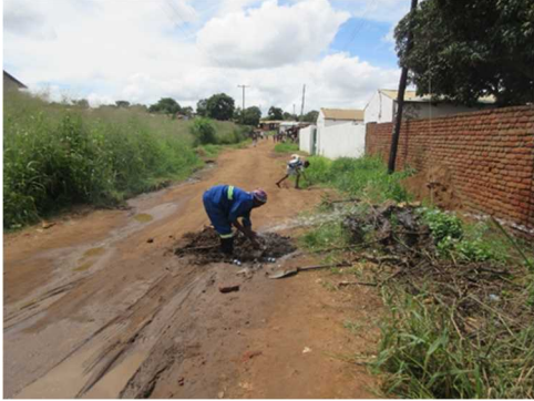
D3 漏水修理状況 2020年2月
