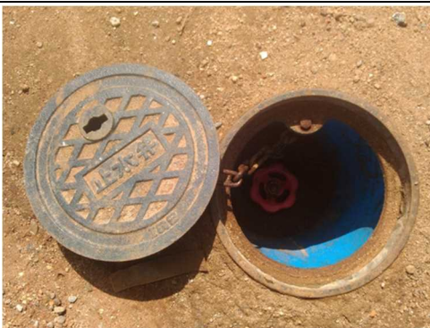
バルブボックス据え付け 2019年12月
